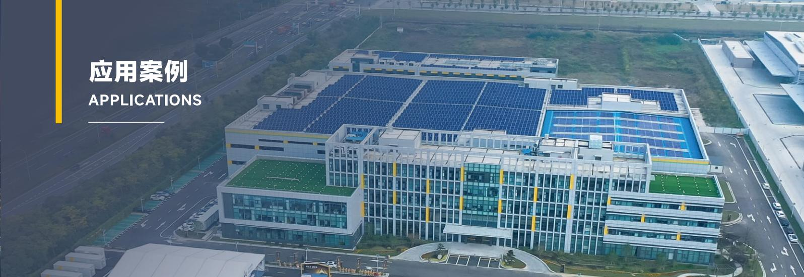
以沃太能源全球总部通州园区为试点，建成了集双碳管理、能耗监测、光伏、储能、充电桩、楼宇自控、安防、消防、数字孪生等 14 个模块于一体的国内领先的低碳智慧园区云平台，于 2023 年 10 月投运，对园区内 1.2MW 分布式光伏、2.5MW/7.5MWh 储能、478kW 充电桩、1MW 空调、30kW 光储一体机以及各类设备进行运维监测与管理。
