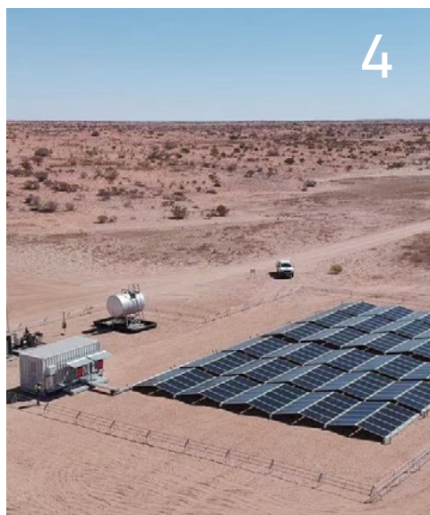
3 光储柴离网 100kW/206kWh 阿联酋·阿布扎比
