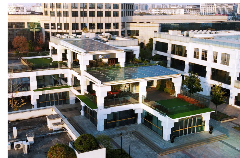
沃太能源苏州分公司屋顶光伏项目
