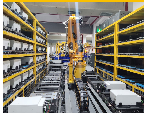
电池老化循环过程的优化改造（南通生产基地）
